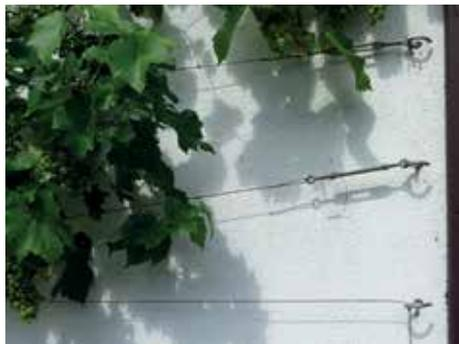
Les tendeurs permettent de retendre les fils.
